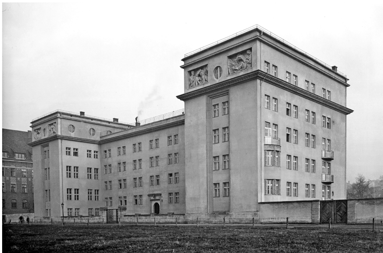
Budynek seminarium, 1929; w zasobie NAC, sygn. 3/1/0/15/693
