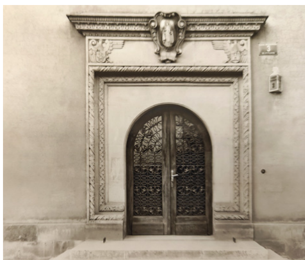
Portal główny, fot. Stanisław Mucha, 1934; w zasobie AAdK, Zbiór fotografii, sygn. 5045
