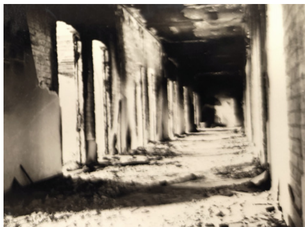
Budynek Śląskiego Seminarium Duchownego, zniszczenia na skutek pożaru pokoiów od strony al. Mickiewicza na poziomie I piętra, stan w 1948 r.; w zasobie AAdK, Zbiór fotografii, sygn. ZF 367
